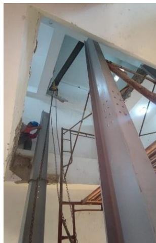
Pemasangan Scaffolding dan Konstruksi Baja Lt 1
