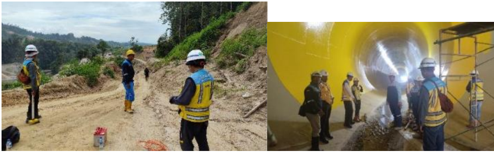
Pengujian MASW di Quarry Selabung pada Pekerjaan Pembangunan Bendungan Tiga Dihaji Kab. OKU Selatan
