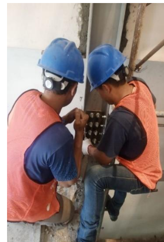
Pengencangan Baut Penyambung Besi Konstruksi dengan Kunci Torsi
