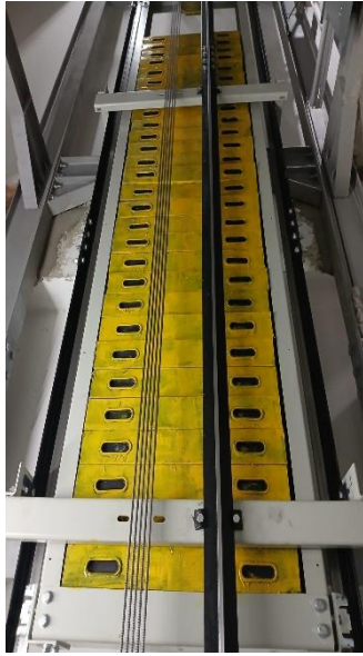
Finising Pengecatan Ulang CWT pakai Warna Kuning
