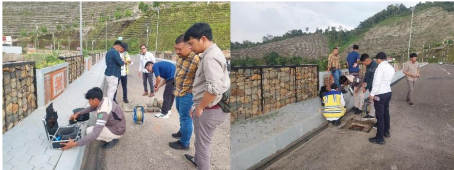
Pemantauan kondisi lubang inclinometer dengan menggunakan kamera downhole pada Bendungan Ameroro
