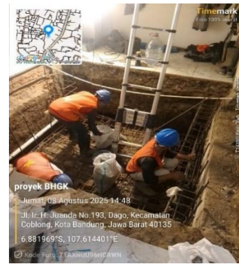
Pemasangan WireMesh pada Lantai Pit
